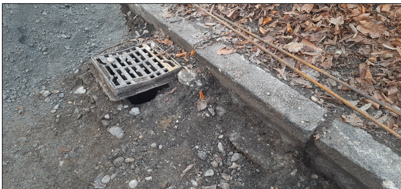
Figura 4: particolare dello scavo e della stratigrafia da cui non si denota la presenza di radici
