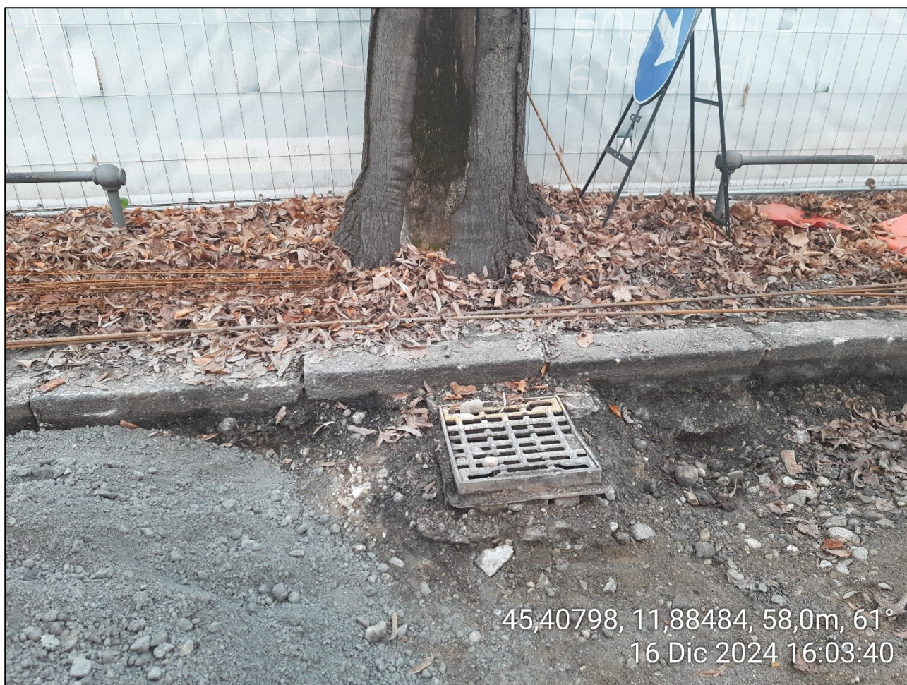
Figura 5: particolare di un taglio con lesioni antecedenti al cantiere
